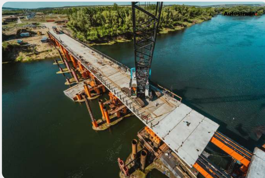
Будівництво на Вінничині нового моста між Україною і Молдовою
